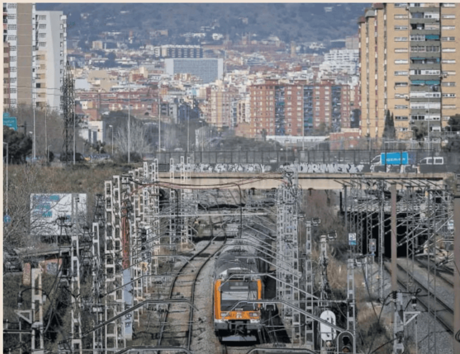
Un convoy de Rodalies de Renfe de la línea R2 circula por las vías del tren a su paso por la zona franca; de fondo, el área metropolitana de Barcelona. ALBERT GARCIA
